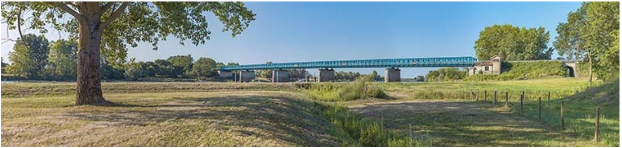
Vue d'ensemble du pont de Chauvort, depuis l'amont.
