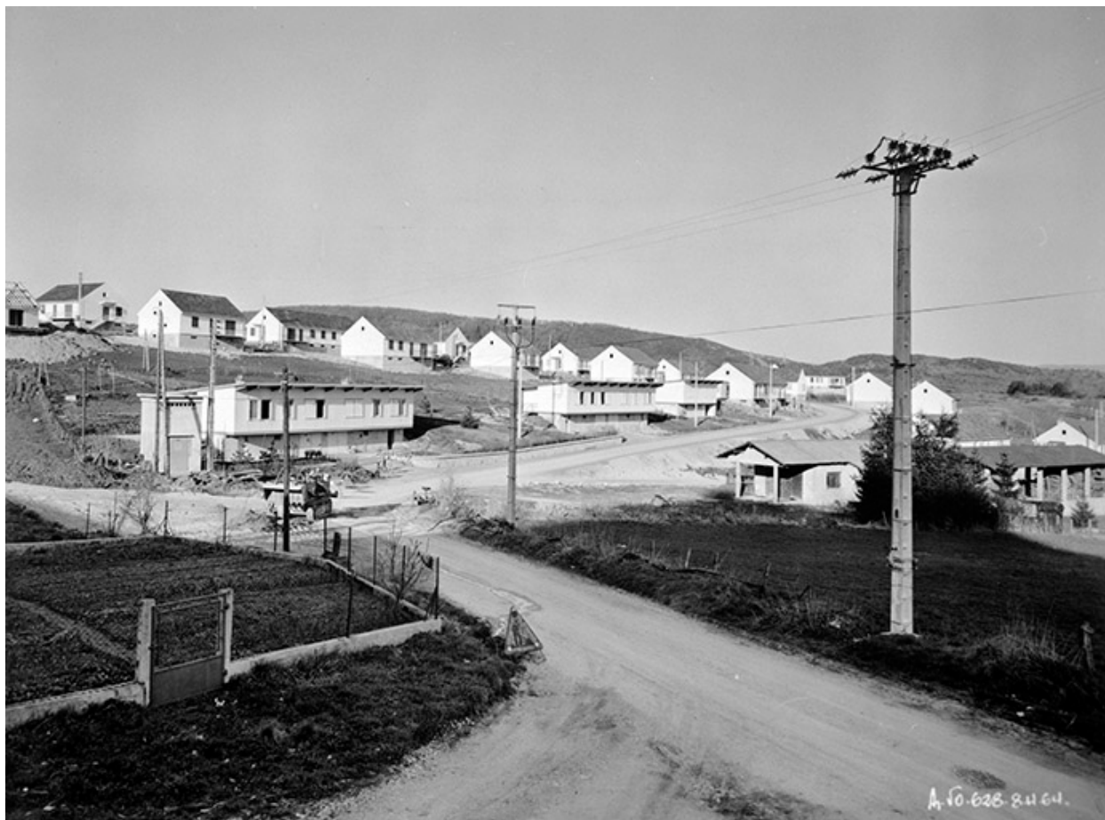
Cité du Closey à Orgelet. Vue générale.
