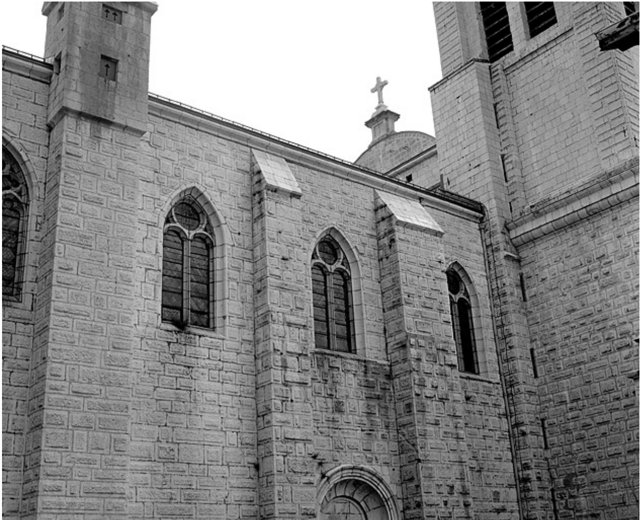
Détail des travées occidentales du flanc nord.
