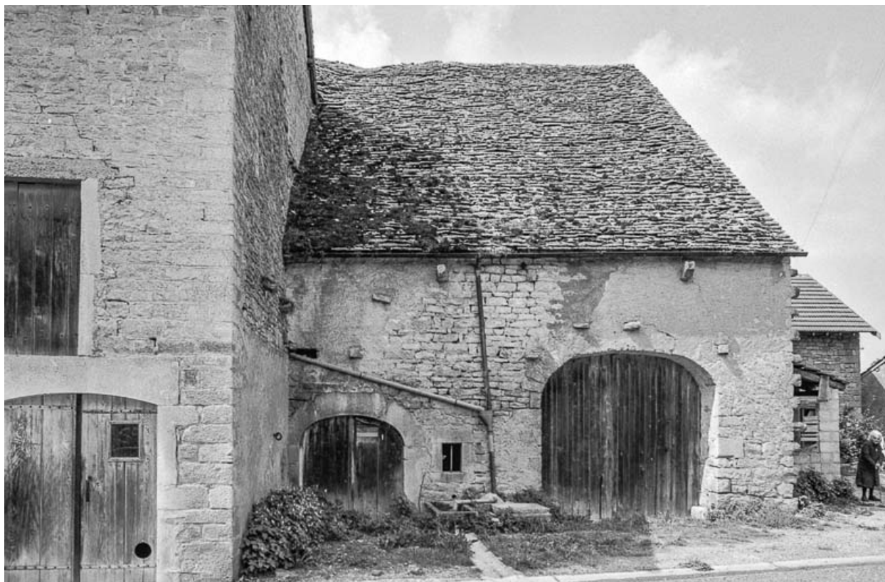
Ferme cadastrée 1951 E1 79 (droite) : façade sur rue.
