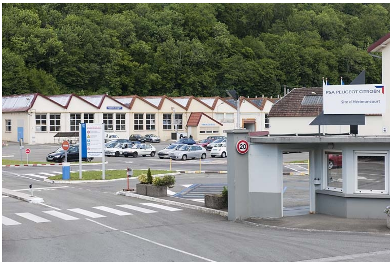
Vue d'ensemble de l'entrée.
