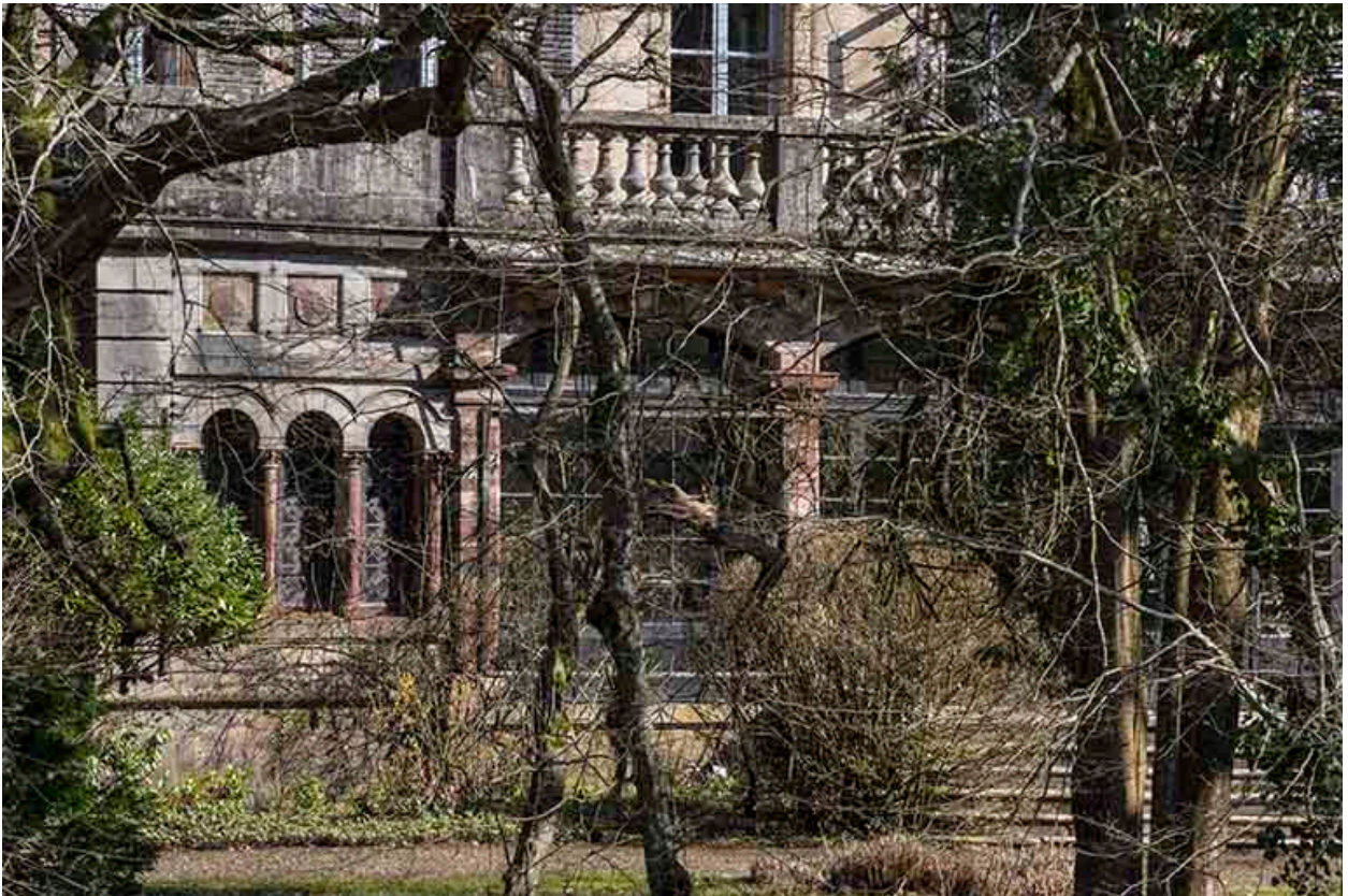
Vue du rez-de-chaussée, façade sud-ouest.
