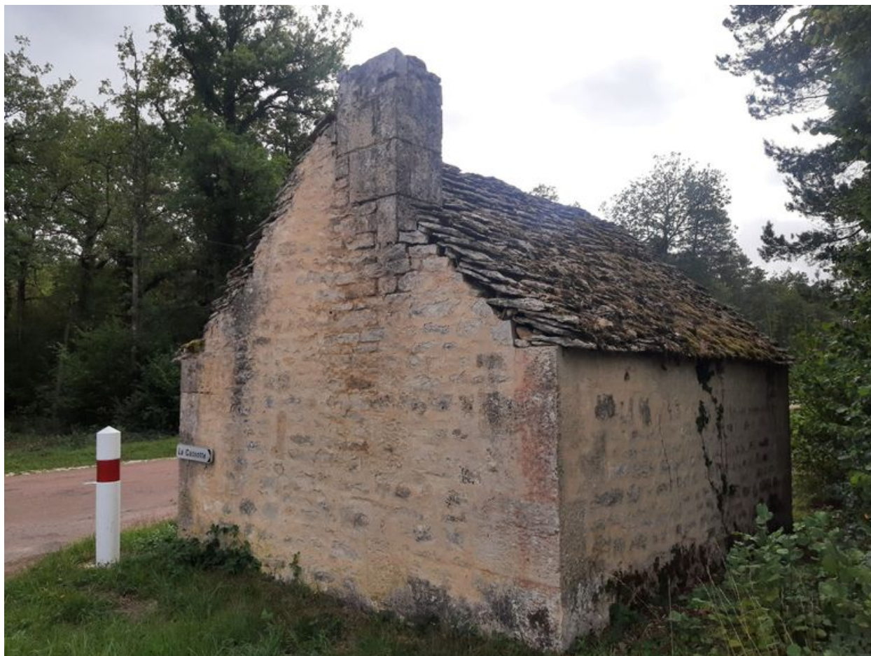
Vue de l'élévation ouest de la cabane.
