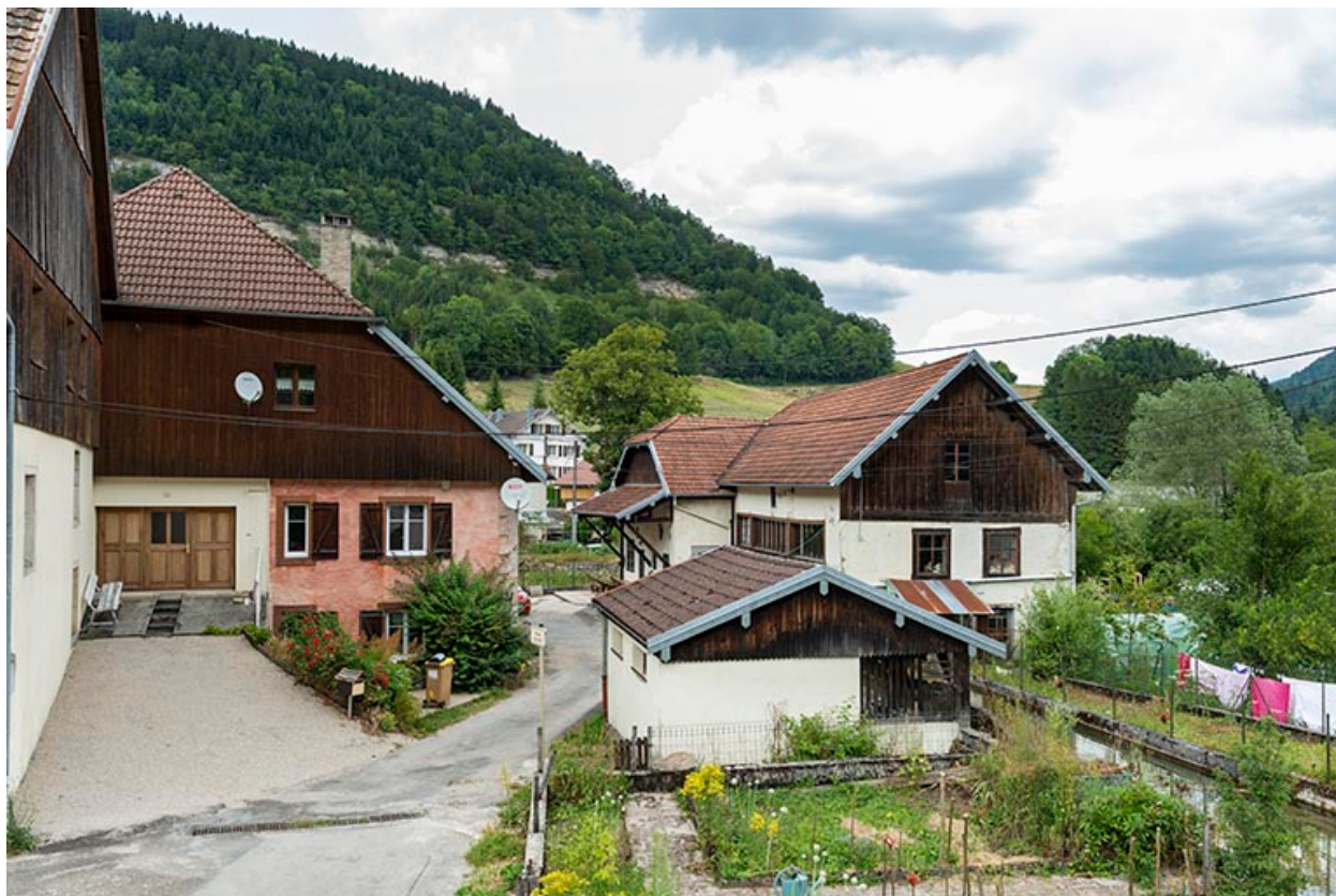
Maison et forge, depuis le sud.
