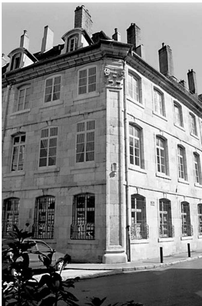
Vue d'ensemble éloignée.
