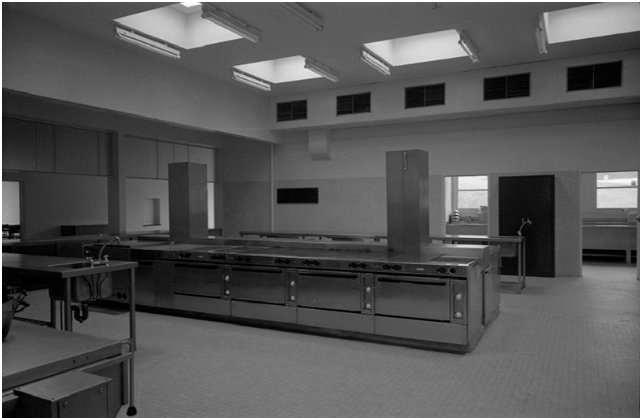
Vue intérieure des cuisines, s.d. [vers 1965].
