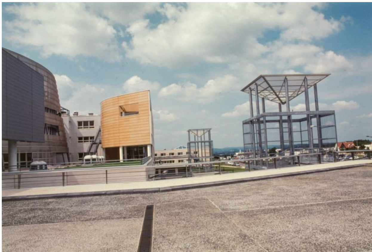
Façade postérieure, vue de la terrasse.
