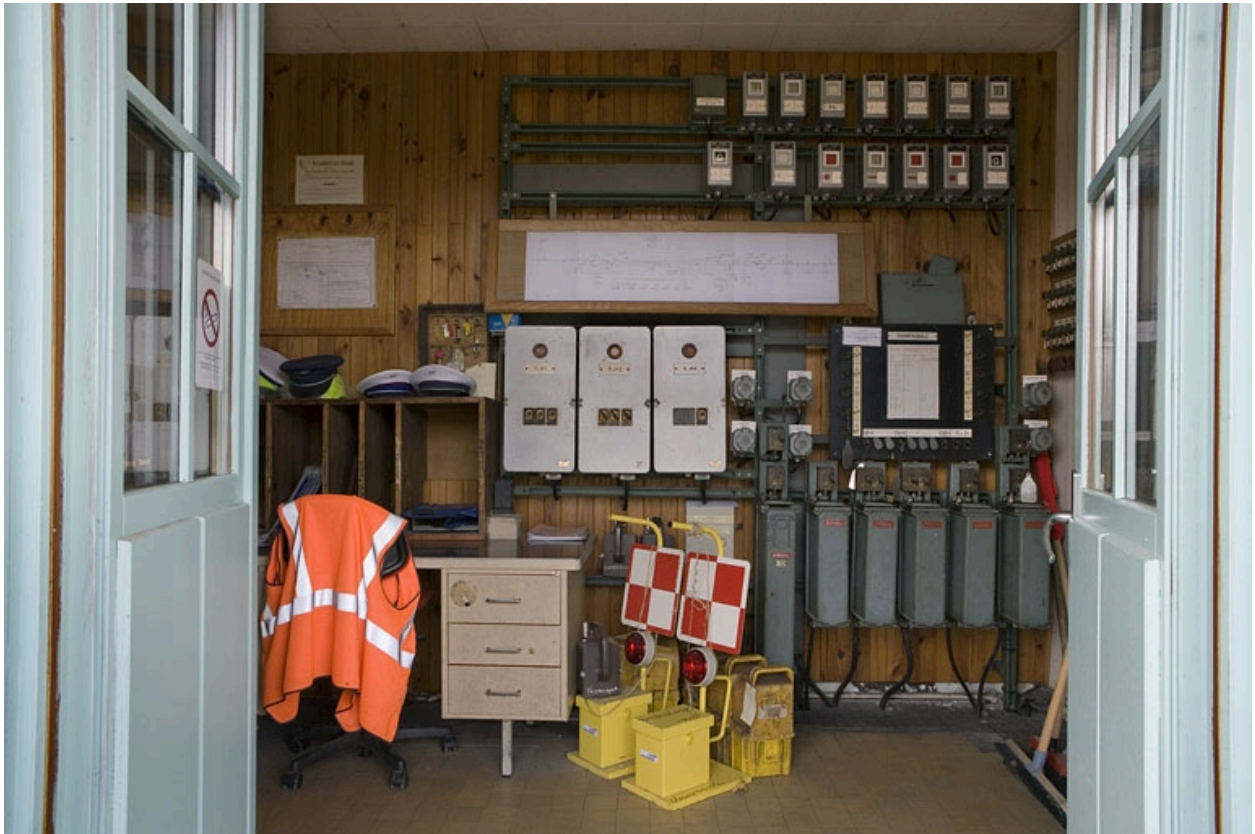
Vue d'ensemble du bureau de l'agent de circulation.
