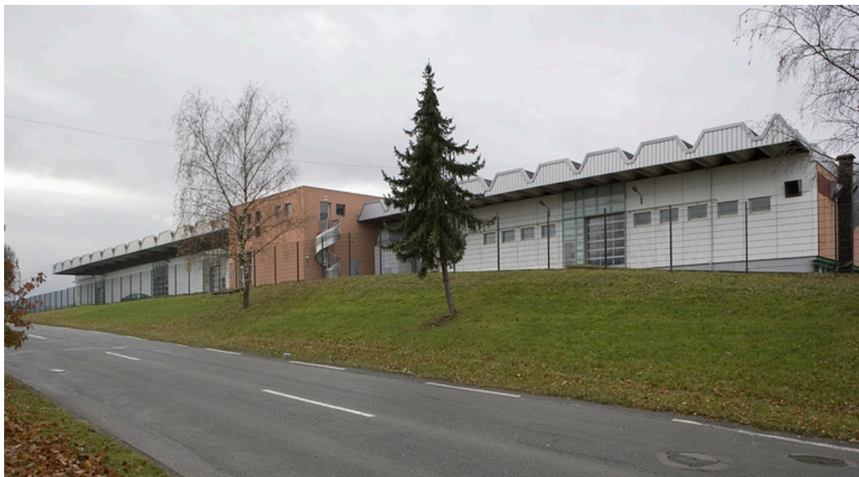
Vue façade postérieure bâtiment F.
