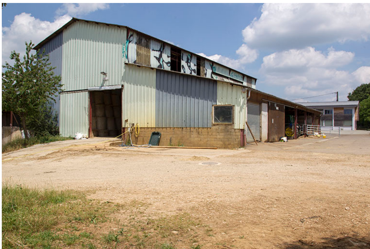
Vue de trois-quart sud-est de l'entrepôt agricole.
