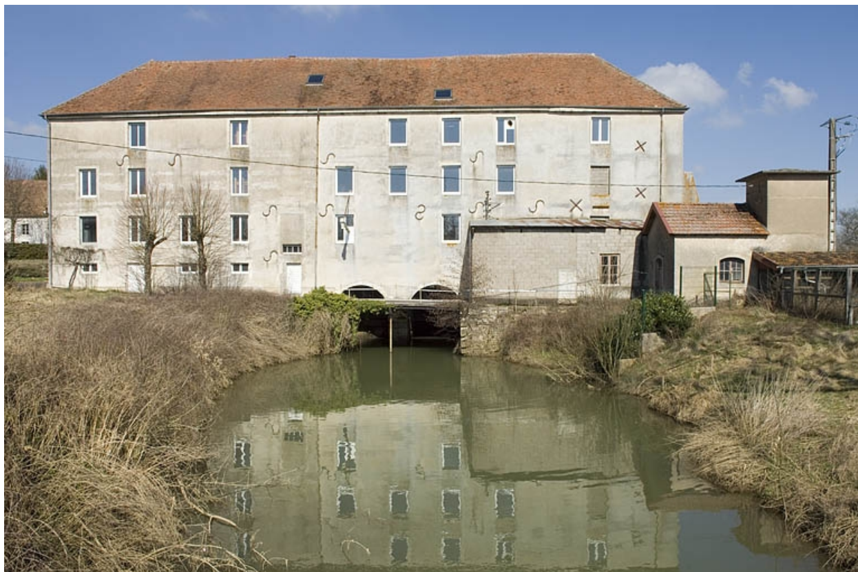
La minoterie et le canal de fuite.
