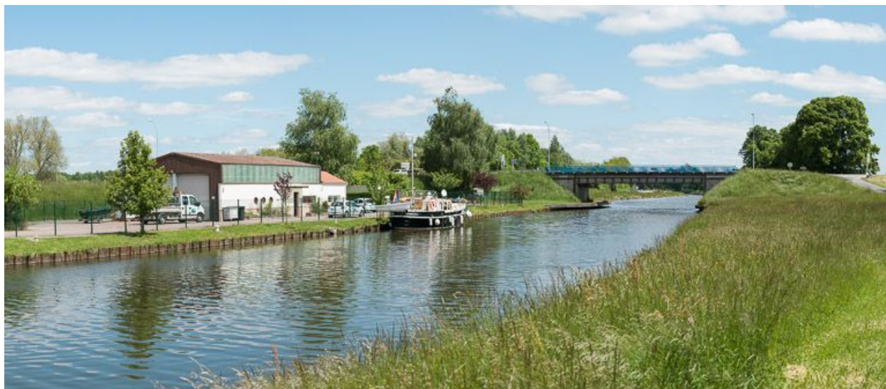
Vue d'ensemble du pont.
