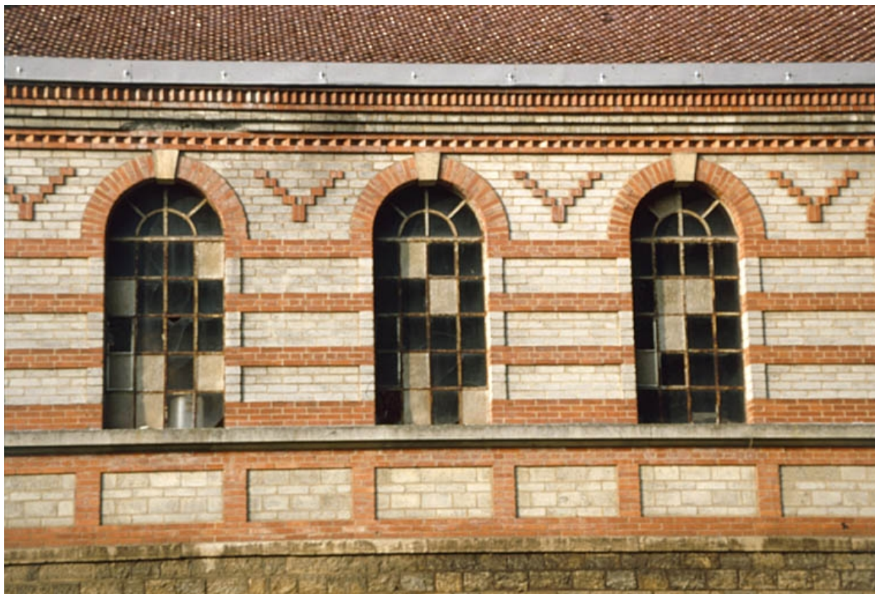
Détail de la façade est de l'orangerie.
