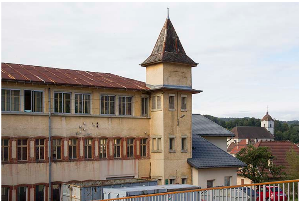
Usine, façade postérieure : tour occidentale.
