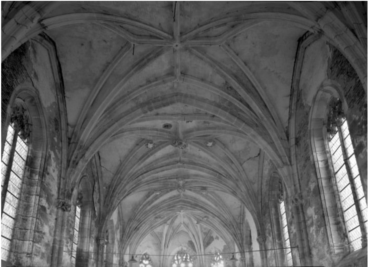
Chapelle de l'ancien château : vue d'ensemble des voûtes.
