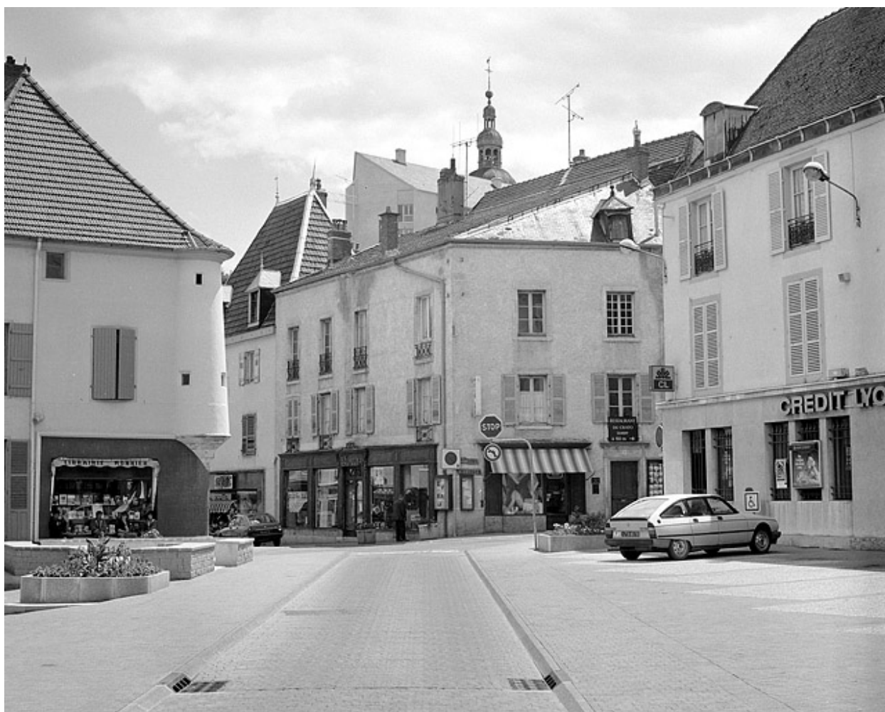
Vue d'ensemble depuis la place Edmond Bour.
