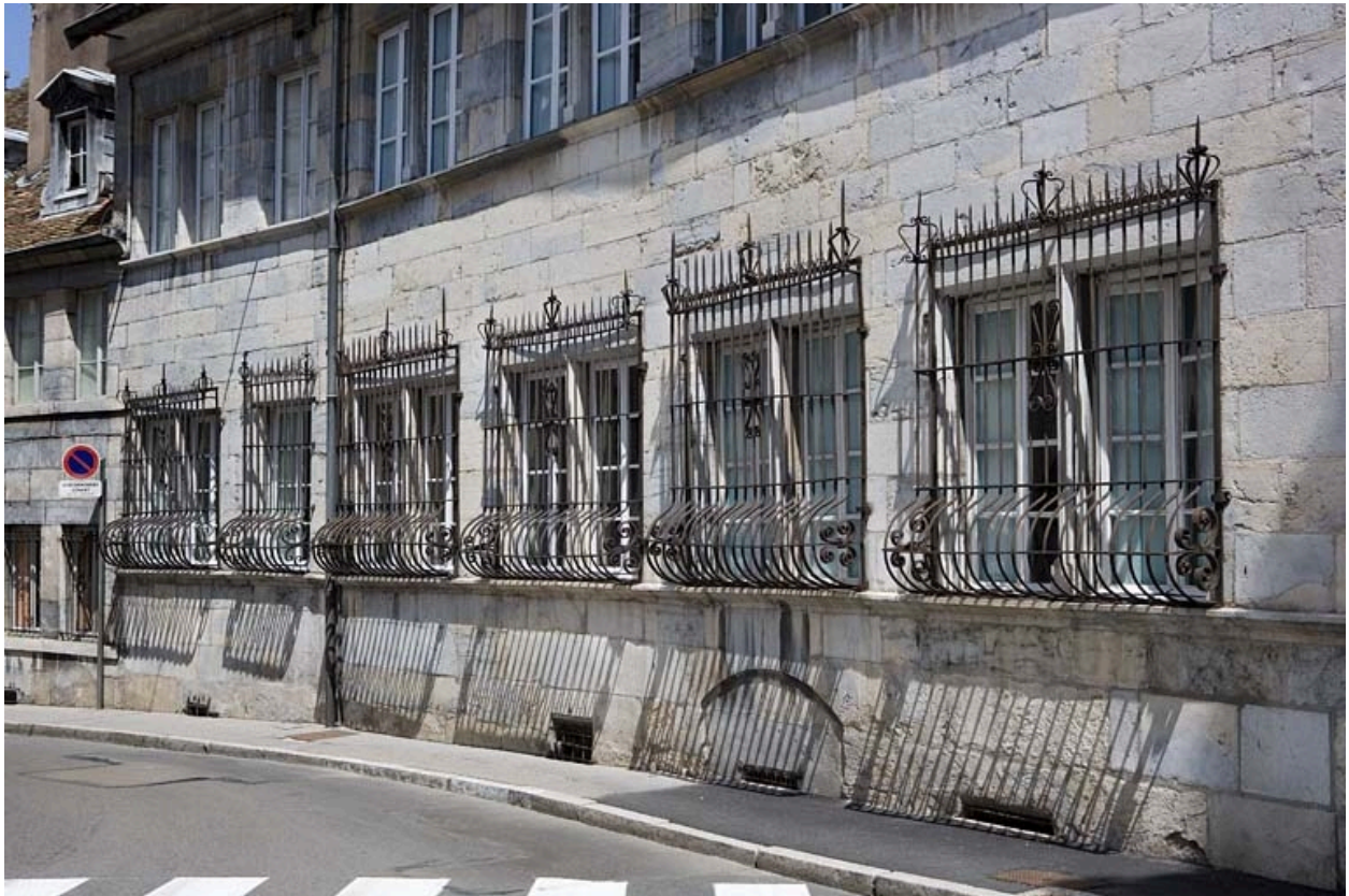
Détail du rez-de-chaussée sur la rue des Martelots.
