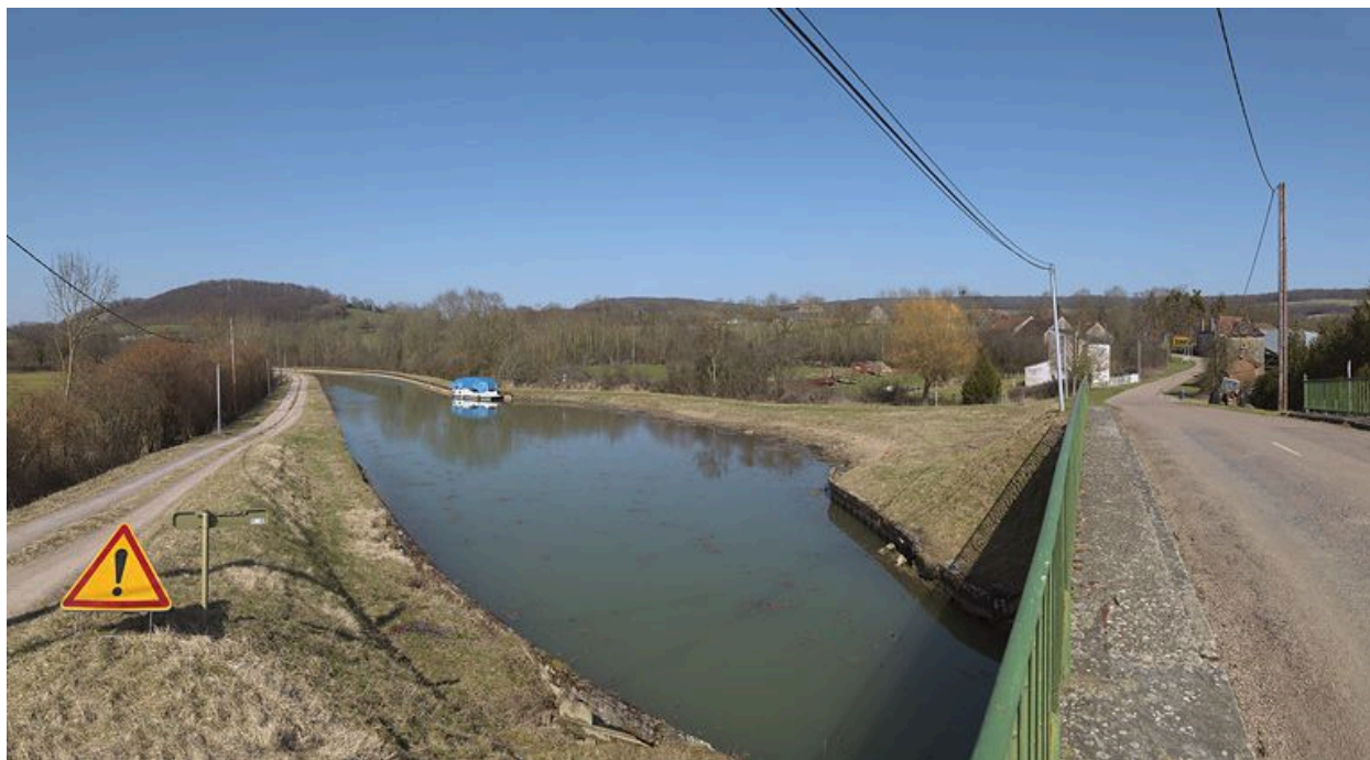
Vue d'ensemble du bassin de port.
