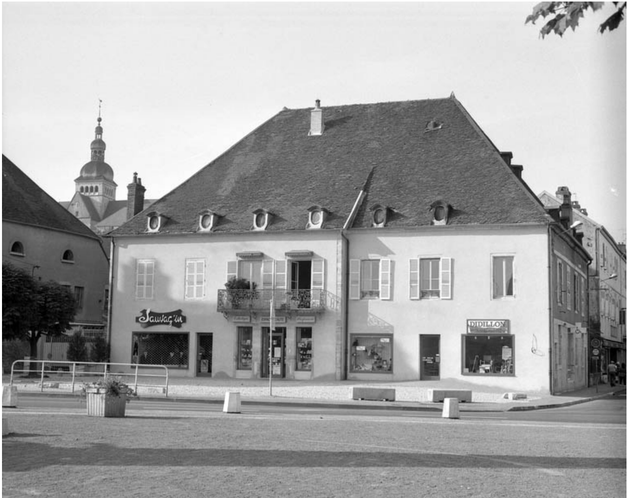
Façade antérieure de la maison, de trois quarts droit.
