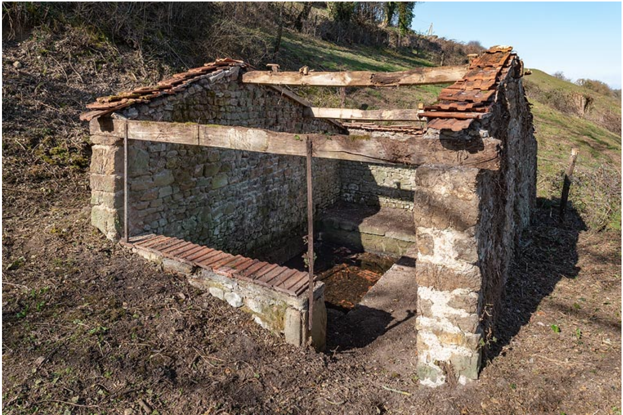
Lavoir du hameau (en cours de restauration)
