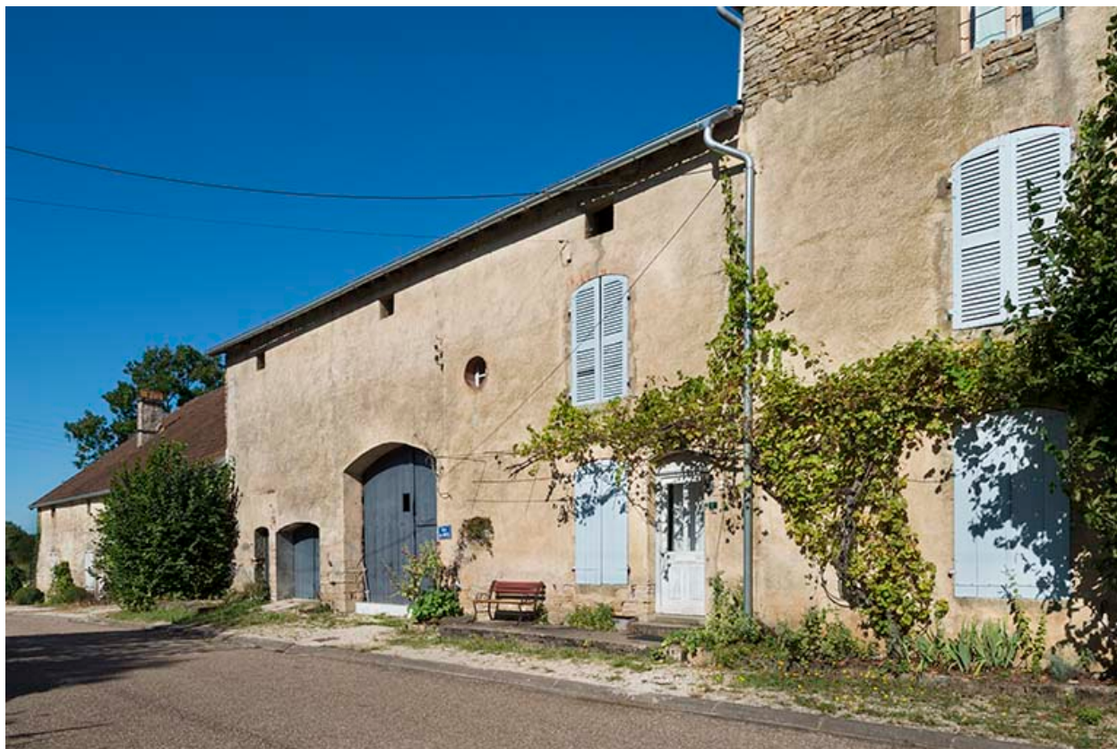
Vue générale depuis le nord-ouest.
