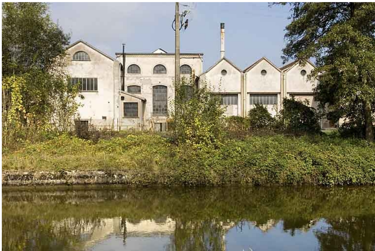
Bâtiments techniques depuis le sud.
