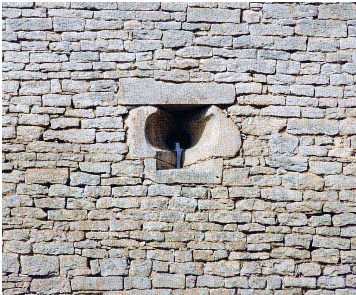
Tour sud, détail : archère-canonnière.
