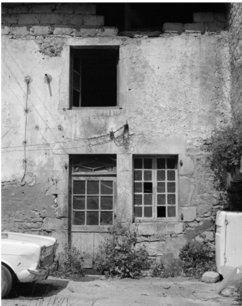
Maison : façade antérieure.
