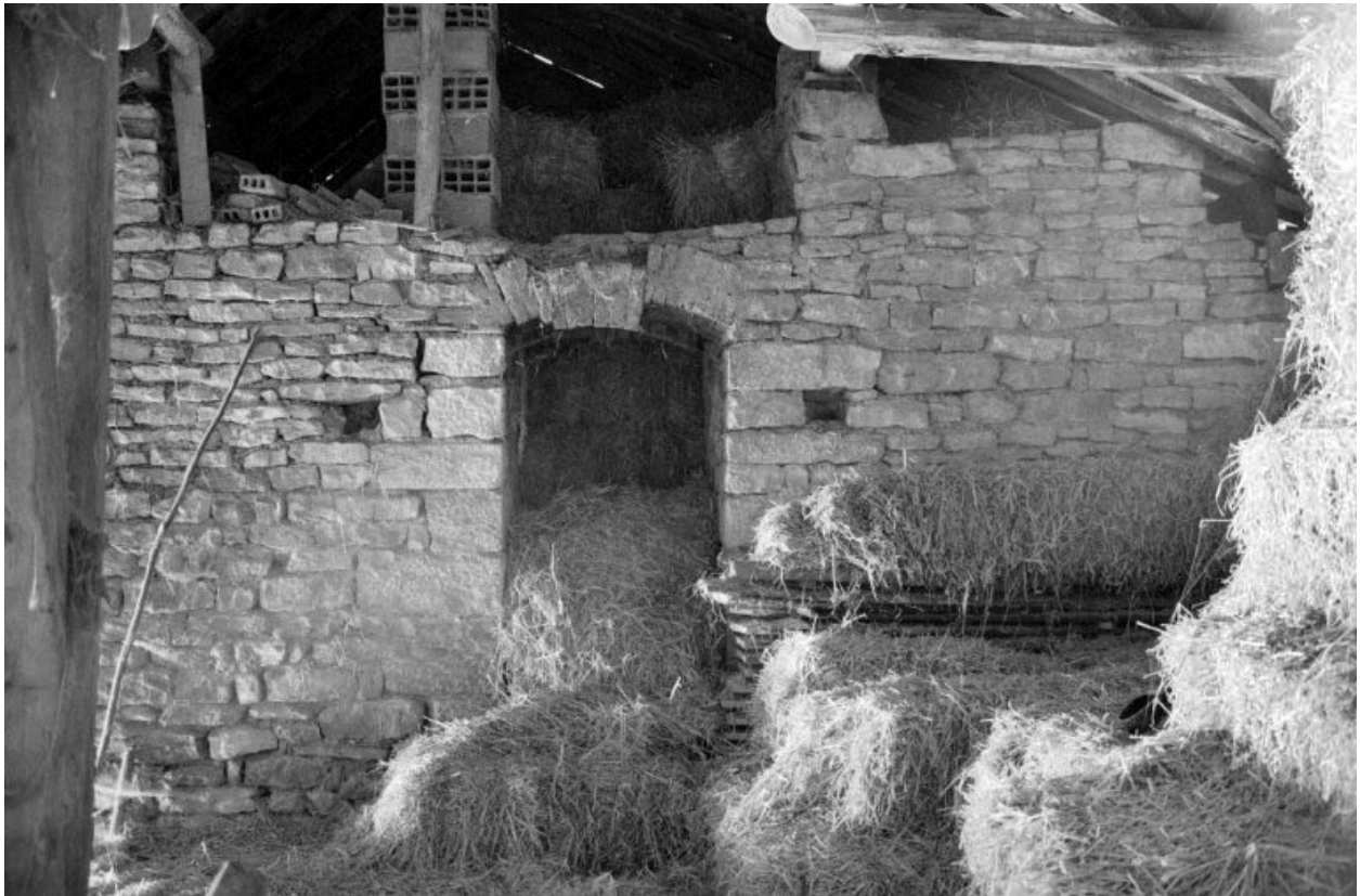
Porte d'enfournement du 2e four (four intérieur).
