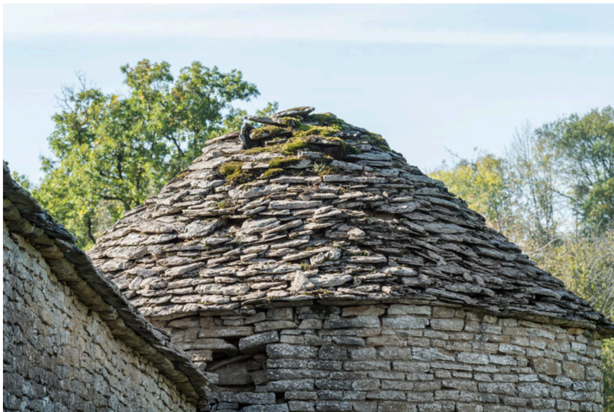
Détail de la toiture tour sud.
