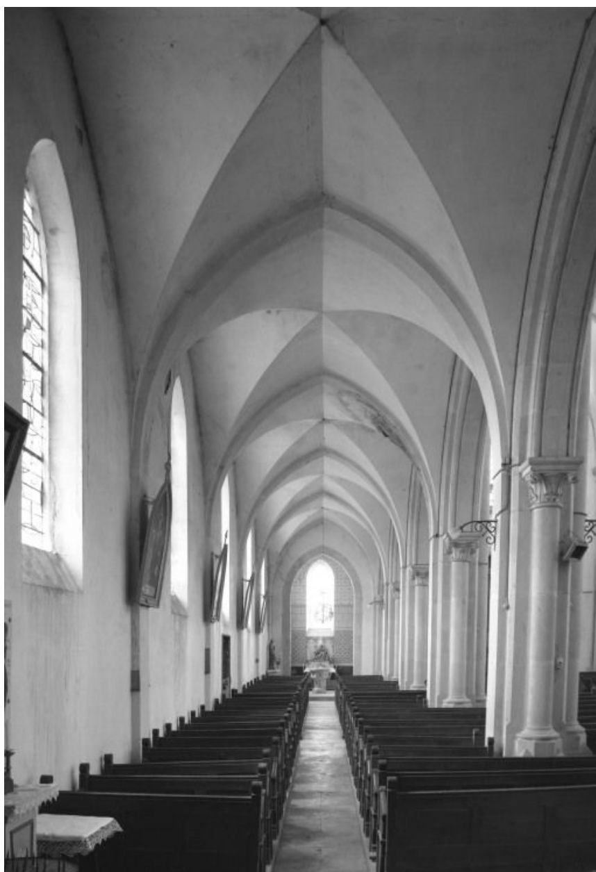
Collatéral droit, vue prise depuis l'entrée
