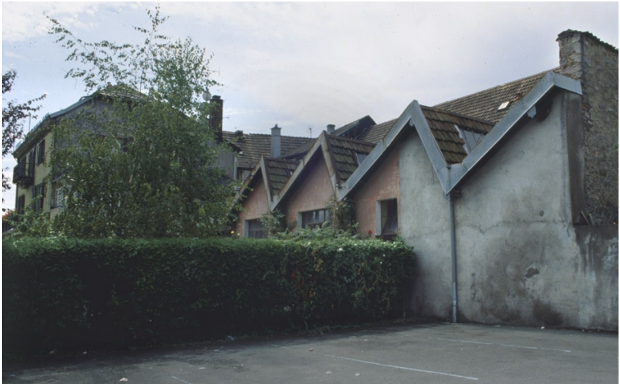
L'atelier de fabrication depuis le nord.
