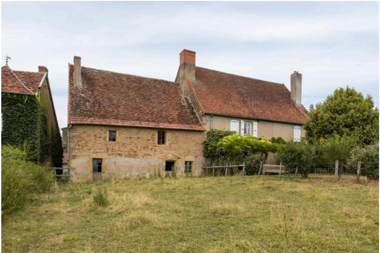
Vue de la façade postérieure de la maison Mommessin
