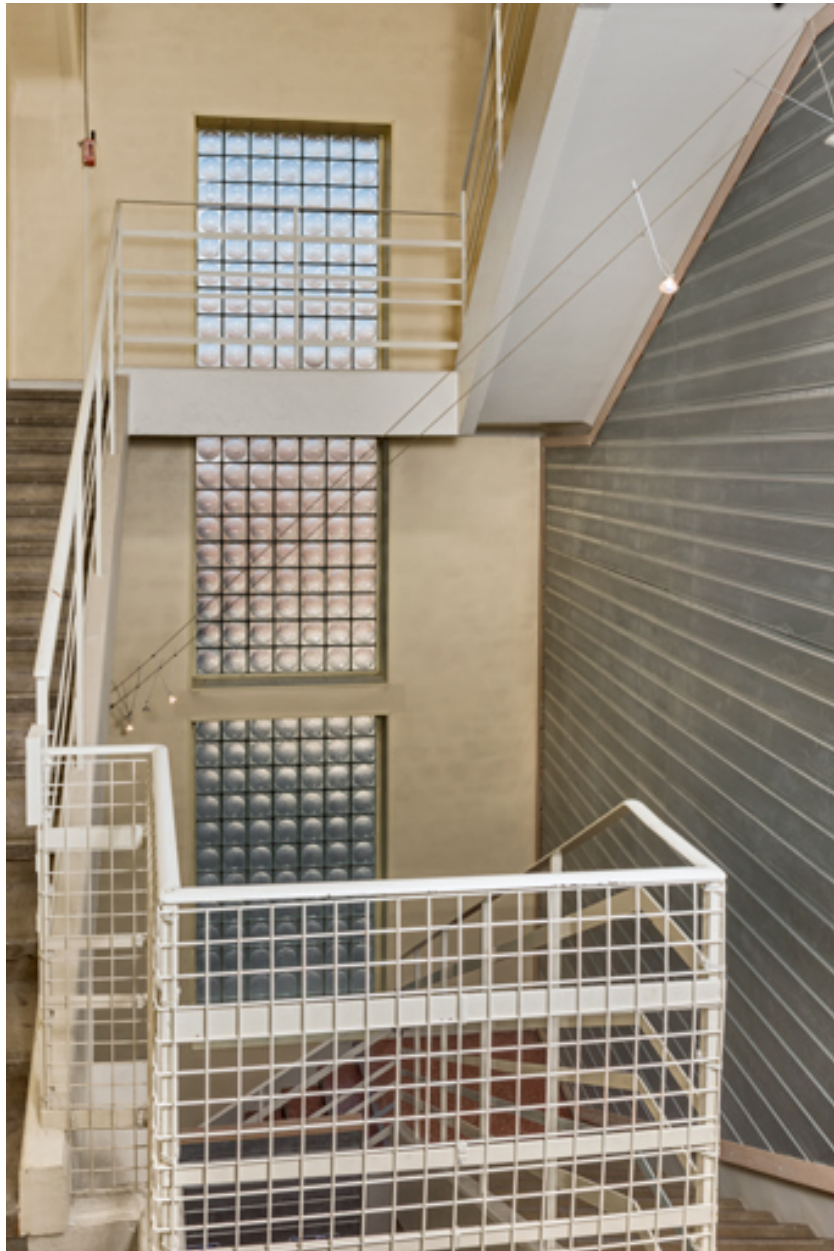
Cage d'escalier, depuis le 1er étage.
