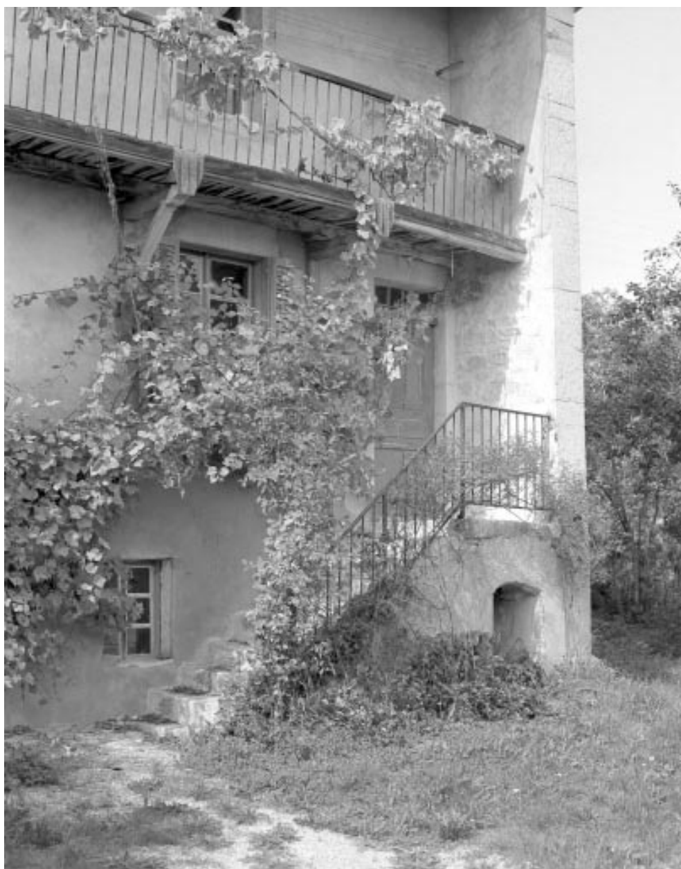
Façade antérieure, accès au logis de droite.
