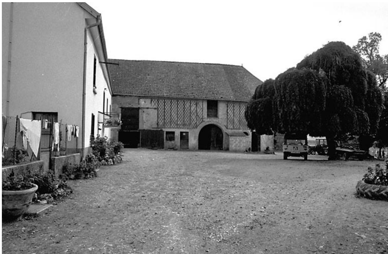
Façades sur cour.
