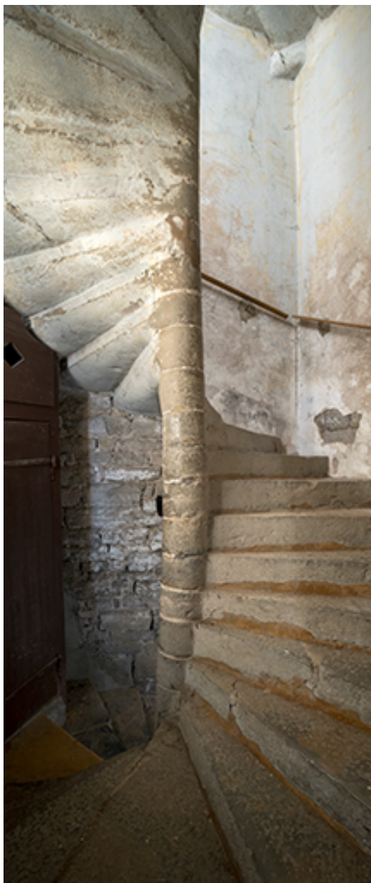
Escalier en vis. Vue depuis le rez-de-chaussée.
