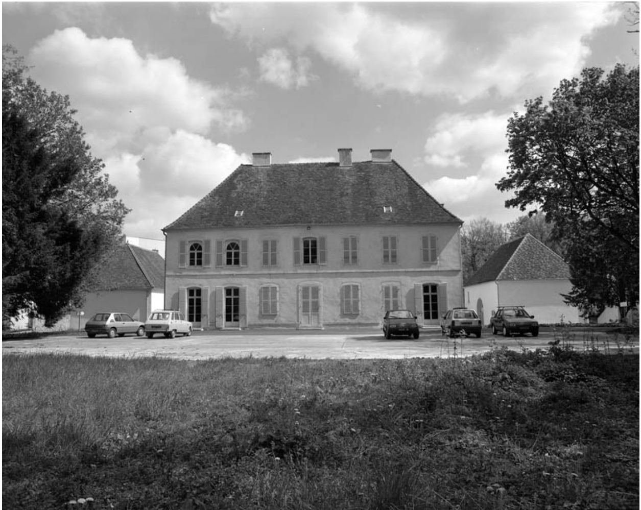
Façade postérieure depuis le parc.
