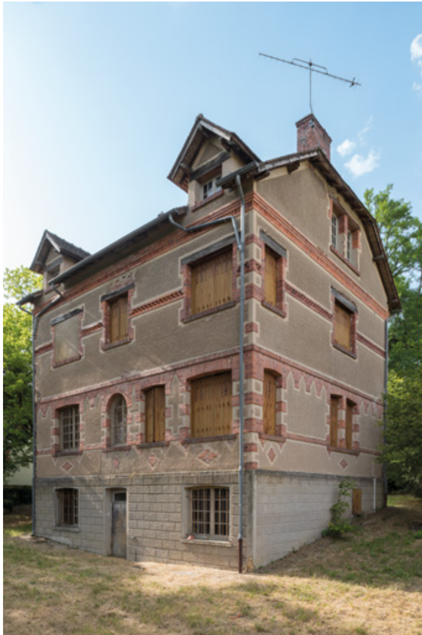
Façade postérieure, vue depuis le sud-est.
