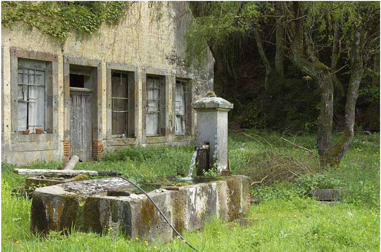
Façades antérieures depuis l'ouest.
