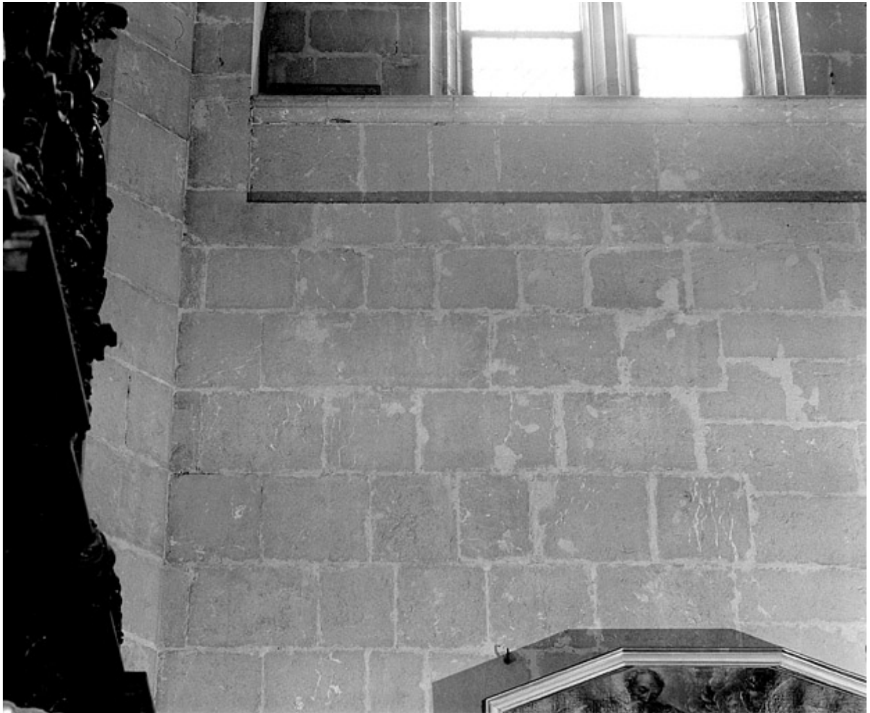
Détail du parement du collatéral sud : couture à hauteur de la sixième travée.
