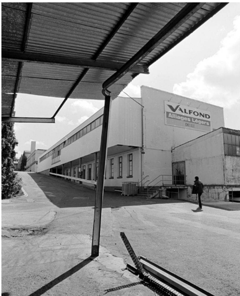
Ateliers de fabrication et vestiaire depuis l'ouest.
