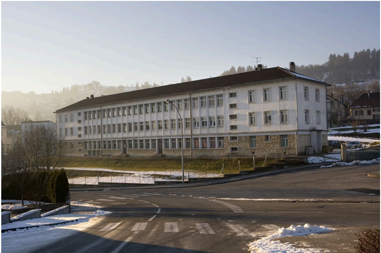
Site ancien : bâtiment du Greta (ancien internat de filles), depuis l'est.
