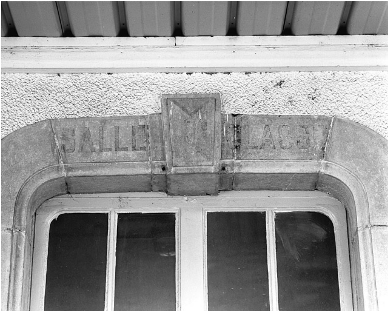
Bâtiment des voyageurs : plate-bande d'une fenêtre de la salle d'attente de troisième classe.
