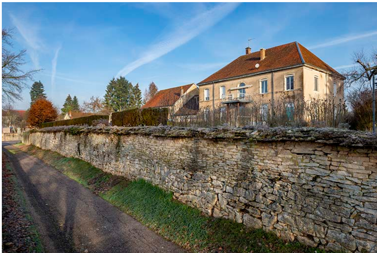
La façade postérieure.
