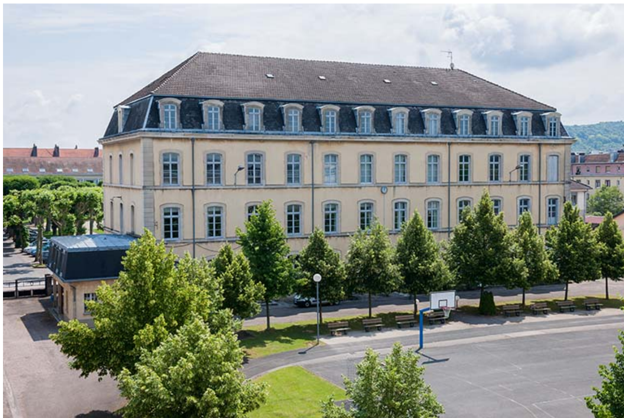
Façade ouest sur cour de l'administration-internat.
