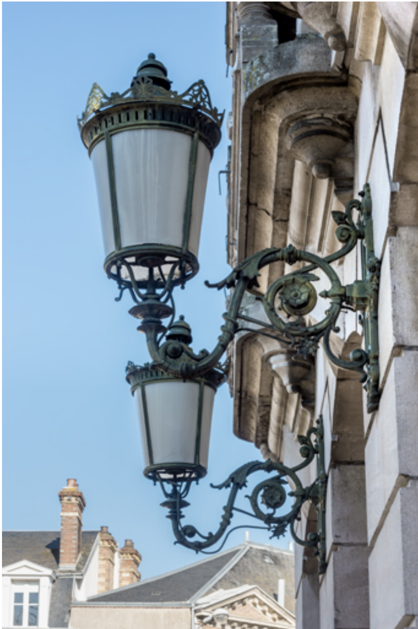
Luminaires d'applique en façade, vus de profil.
