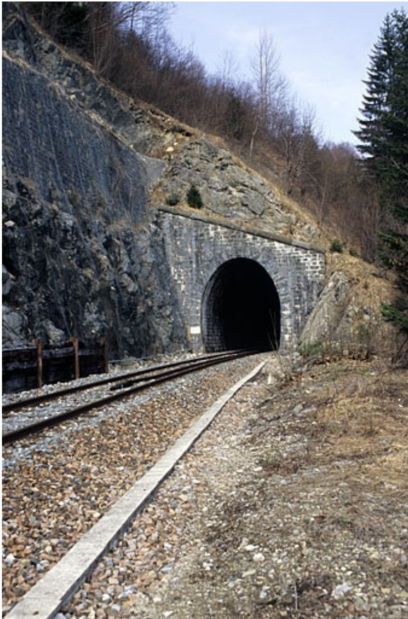
Tunnel : tête sud-ouest (côté La Cluse).
