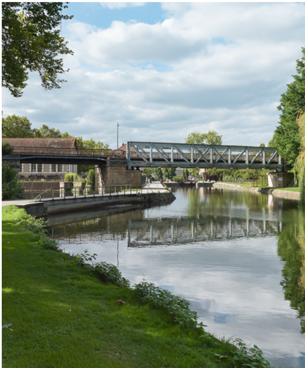
Vue du site.
