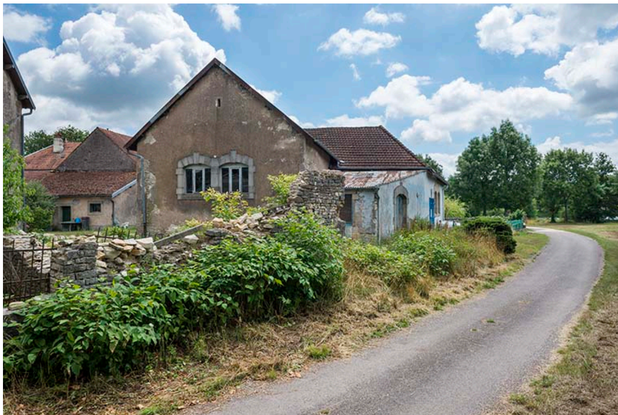
Mur pignon ouest.
